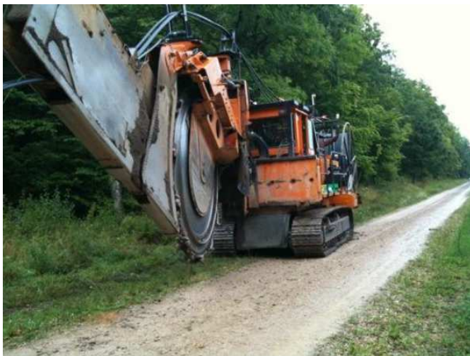
Trancheuse sous-soleuse / dérouleuse de câble
